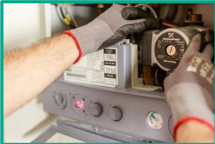
Fig. 90 Trabajo de mantenimiento de una caldera. Imagen obtenida de Canva.com
